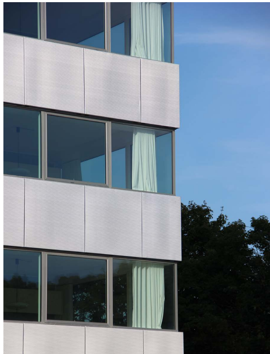
Konstruktionen er trukket tilbage i hjørnerne og giver en naturlig plads til gardinerne, som skjuler søjlen.
