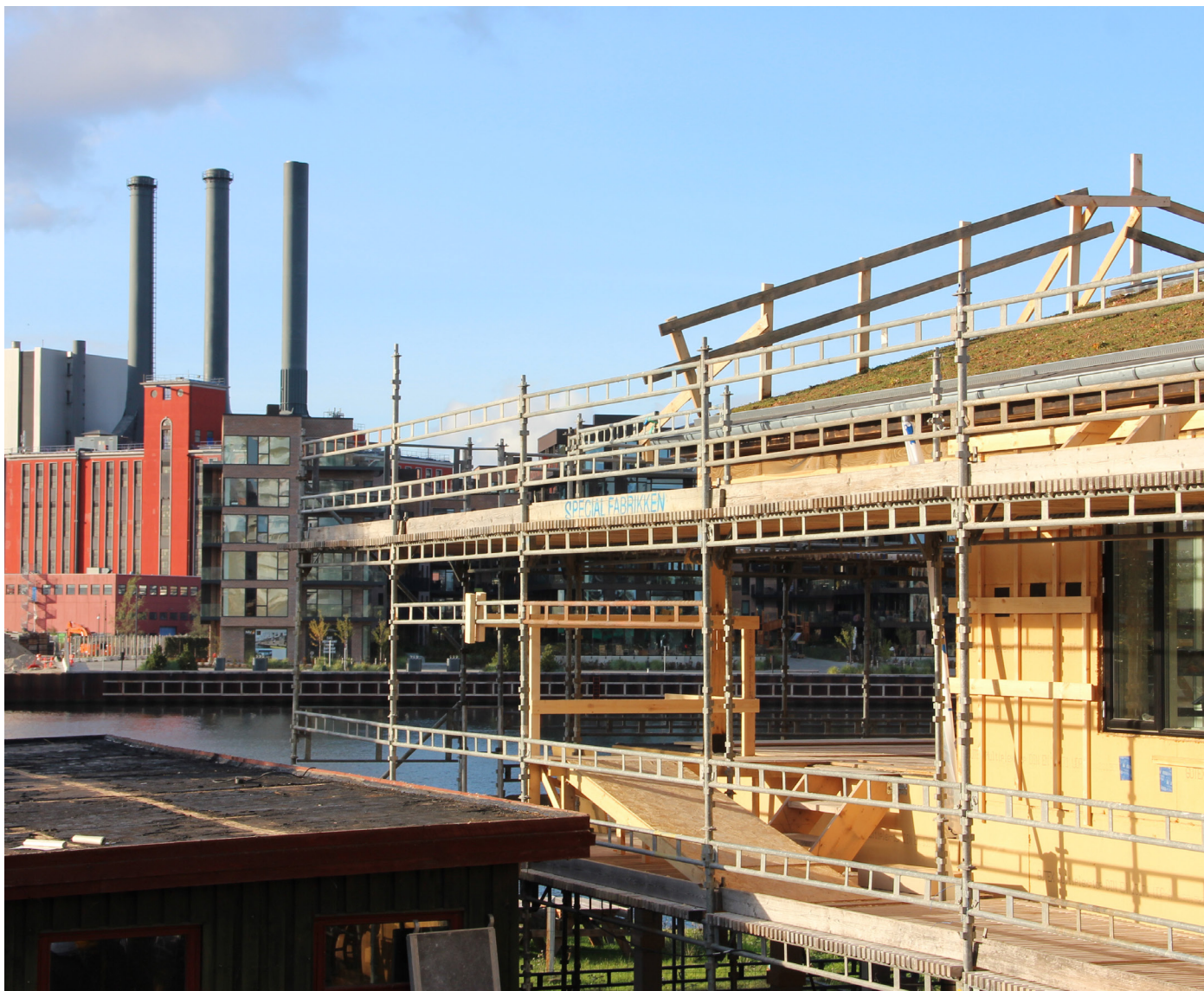
Klubhuset ligger ud til vandet og er endnu omsluttet af stillads. Byggeriet lægger sig imellem det hastigt voksende Islands Brygge og kolonihaveforeningen Nokkens lave bygninger.
