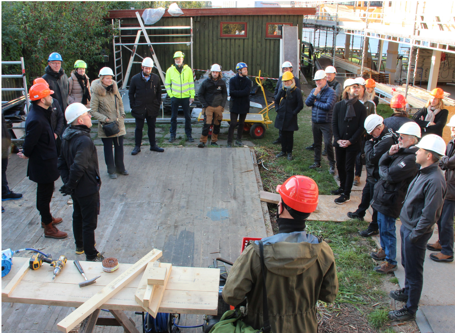
På byggepladsen var der afprøvning af træ søms-pistolen. Når træ sømmene skydes ind, genereres der friktion og varme, der får træets ligning til at "svejs" det omgivende træ og danne en stærk binding.
