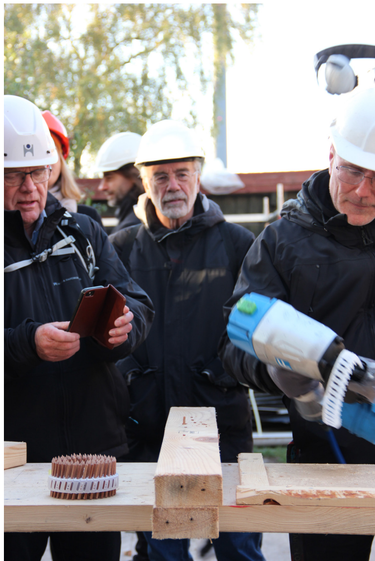
For at minimere brugen af metal i byggeriet er der brugt træ-søm, som skydes i med sømpistol.
